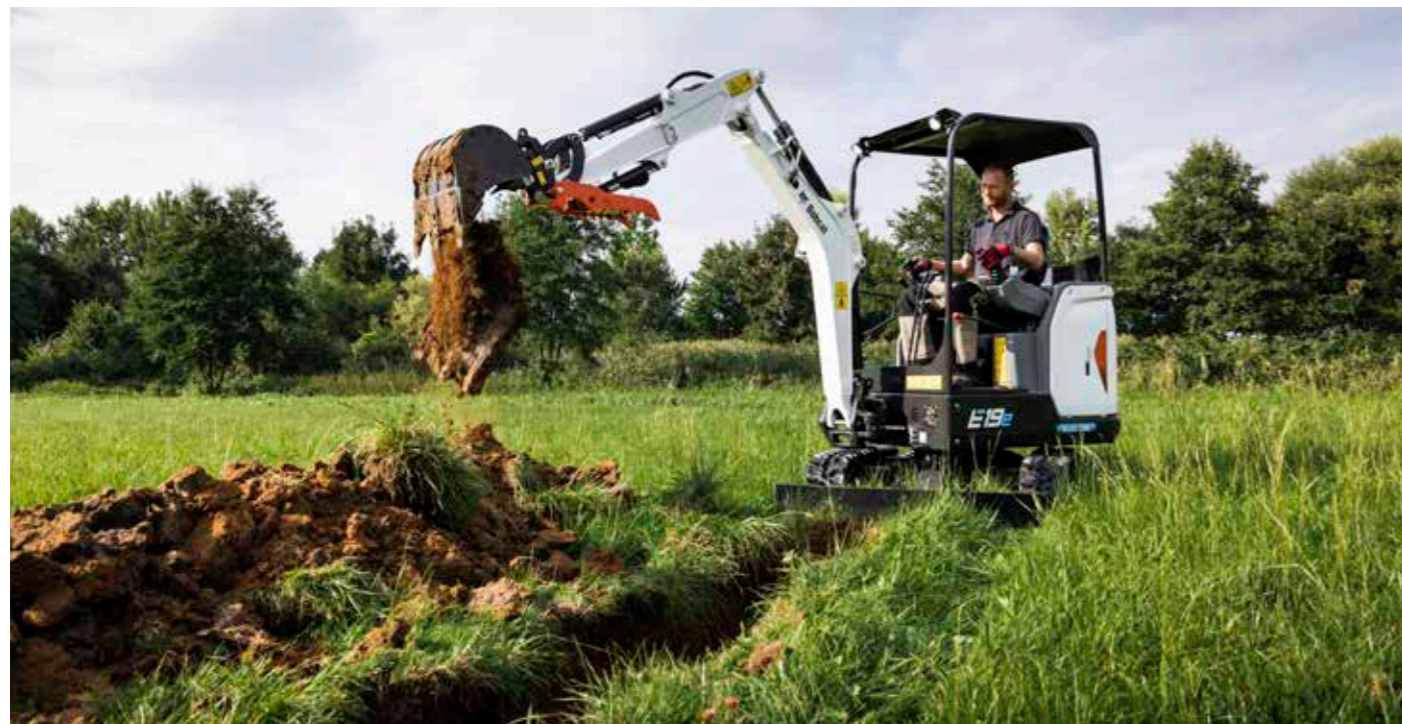
Creación de zanjas con la E19e
